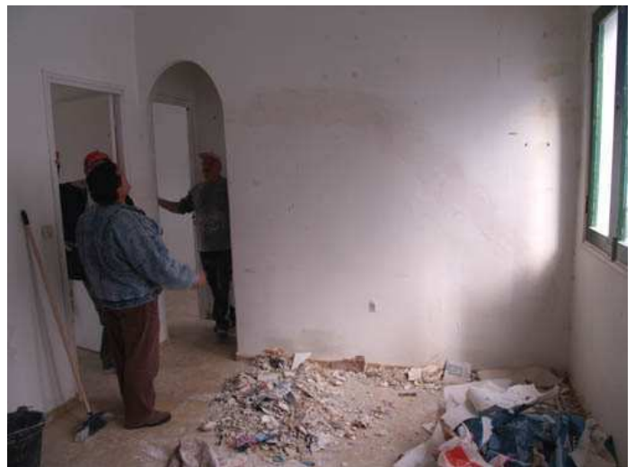
El edil de Obras visita las instalaciones al comienzo de las obras
